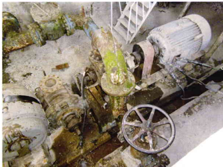
Պատկեր 68: ՀԶԿԼ-ի կողմից շահագործվող վերջ չտրման պոմպայանների մեխանիկական մասերի ծայրահեղ վիճակը (վերանորոգման առաջնահերթություն)
