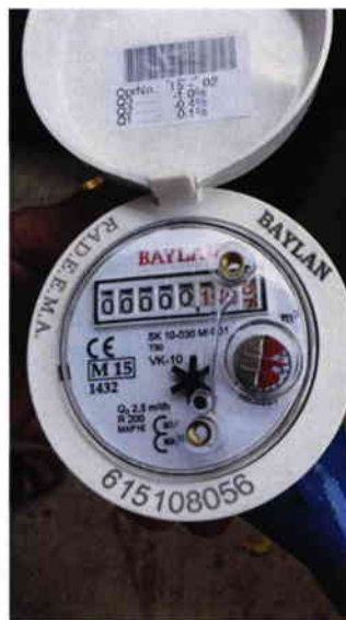
Պատկեր 77. ՀԶԿԼ կողմից օգտագործվող թուրքական Բայլան մակնիշի ջրաչափեր՝ մատչելի, սակայն ցածրորակ և ճշգրտության (ՎԵՈԼԻԱ-ի կողմից խորհուրդ չի տրվում)
