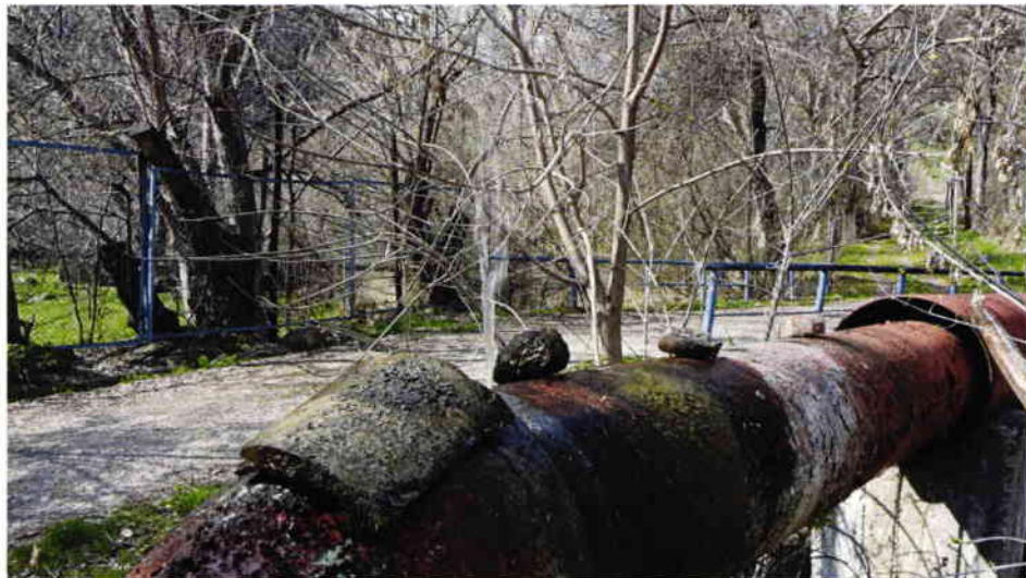
Պատկեր 70: Ցանցի վերանորոգումը կնշանակի նաև հոսակորուստ ունեցող խոխովակների և ջրագծերի փոխարինում
