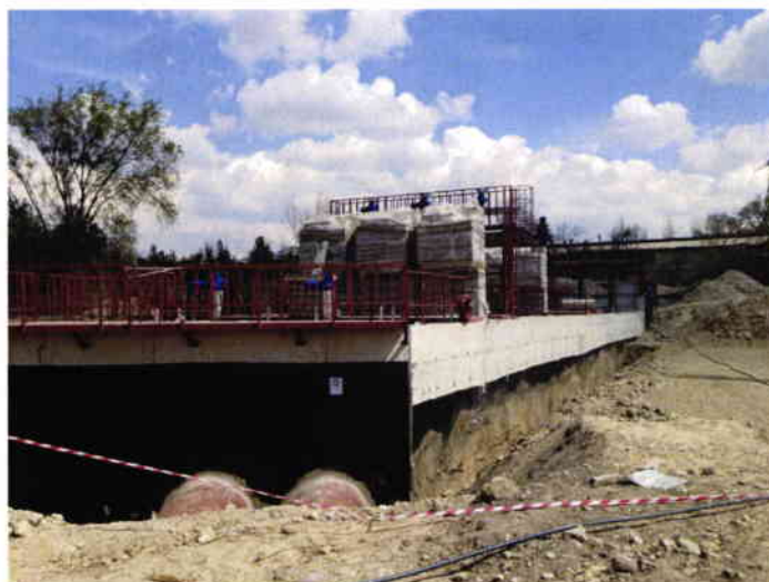
Պատկեր 84: Մեխանիկական մաքրման նոր կառույցի շինարարություն Աերացիա ԿՄԿ-ում
