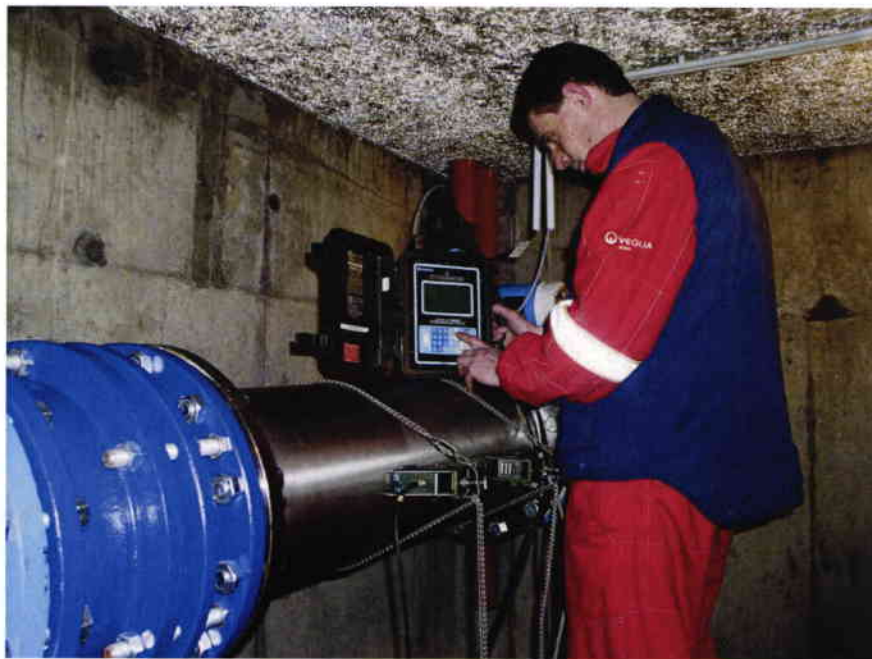
Պատկեր 93. Տարածքի հոսքի չափում՝ գիշերային նվազագույն հոսքի գնահատման նպատակով (ինչպես իրականացվել է Երևանում)
