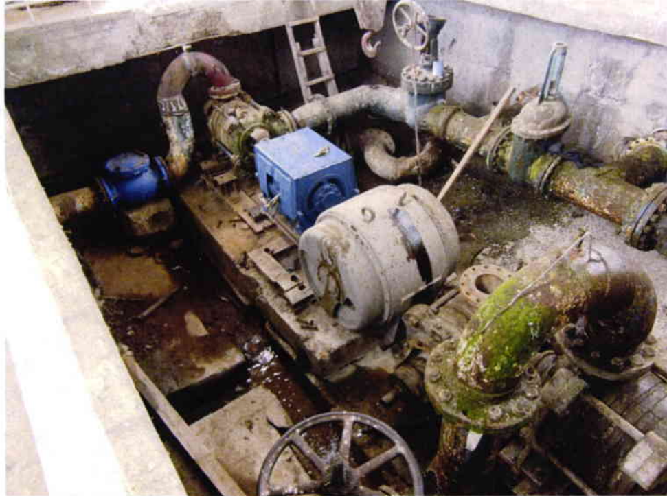
Պատկեր 115: Ամբողջովին վերակազմման կարիք ունեցող հին պոմպակայանի օրինակ (Ագարակի ՊԿ՝ ՀԶԿԸ-ում)
