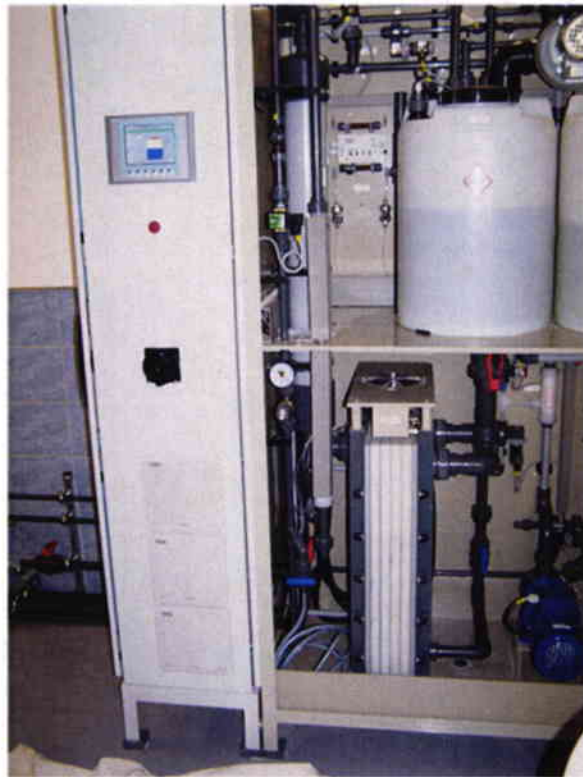
Պատկեր 132. Էլեկտրաքլորացման սարքավորման մանրամասն տեսքը
