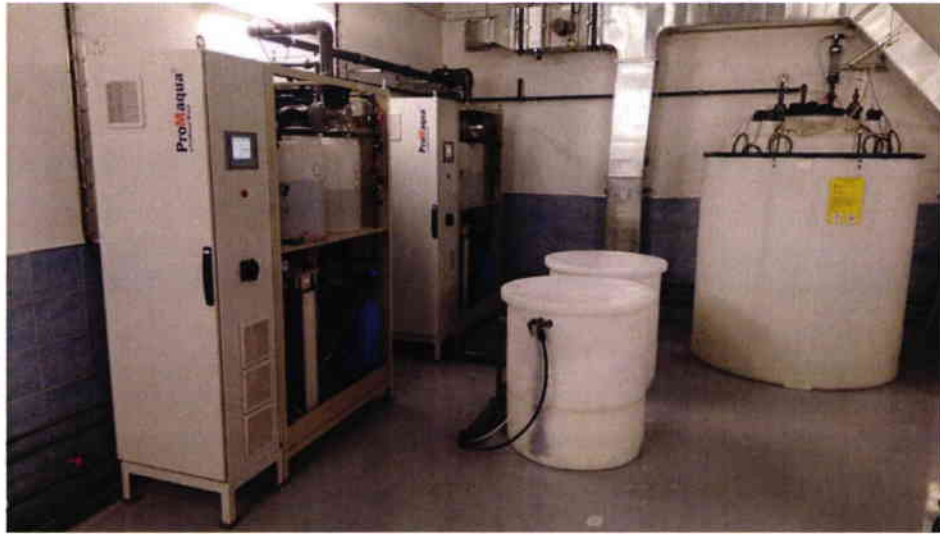
Պատկեր 131. Տեղում քլորի ստացման տեխնոլոգիան ՊՋԿԸ Պրահայում
