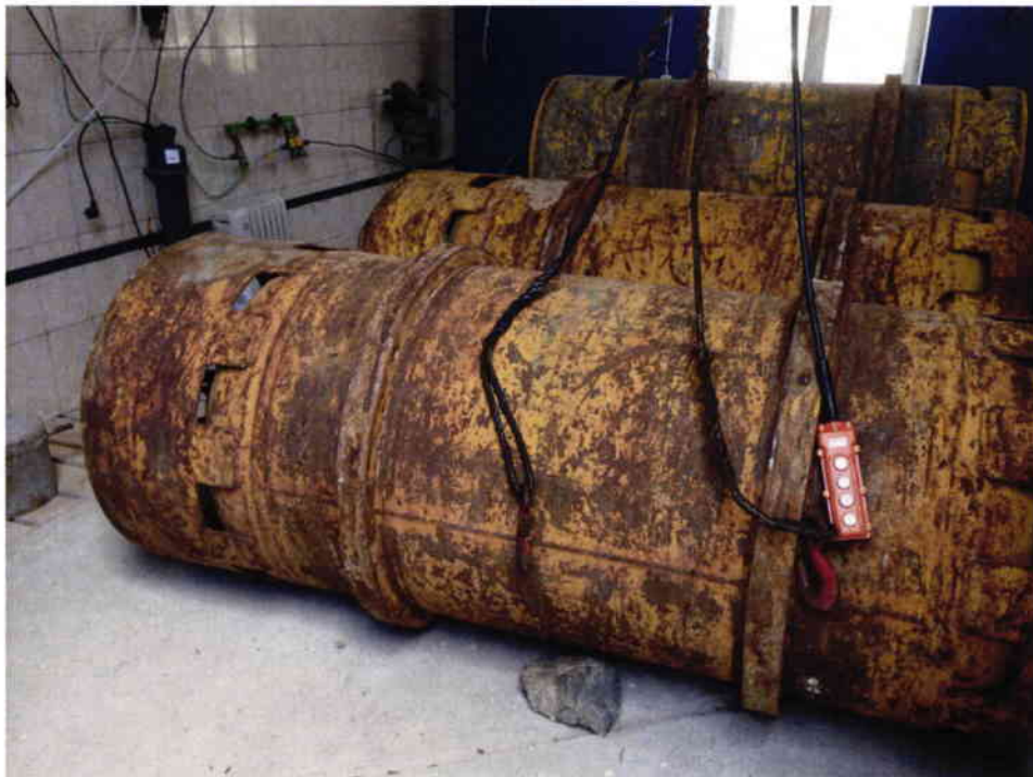
Պատկեր 134. Հեղուկ քլորի բալոնները պետք է փոխարինվեն ավելի ճկուն, ժամանակակից և ապահով էլեկտրաքլորացմամբ
